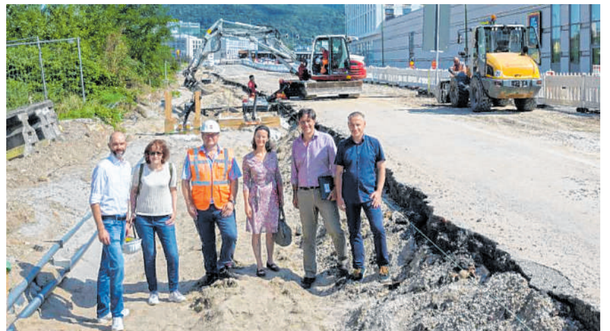
Bürgermeister Jürgen Odszuck (2. v. r.) besuchte die Baustelle in der Eppelheimer Straße. Ab Anfang November soll der Verkehr hier wieder zweiseitig rollen. BILDER (2): HD-PHILIPP ROTHE
