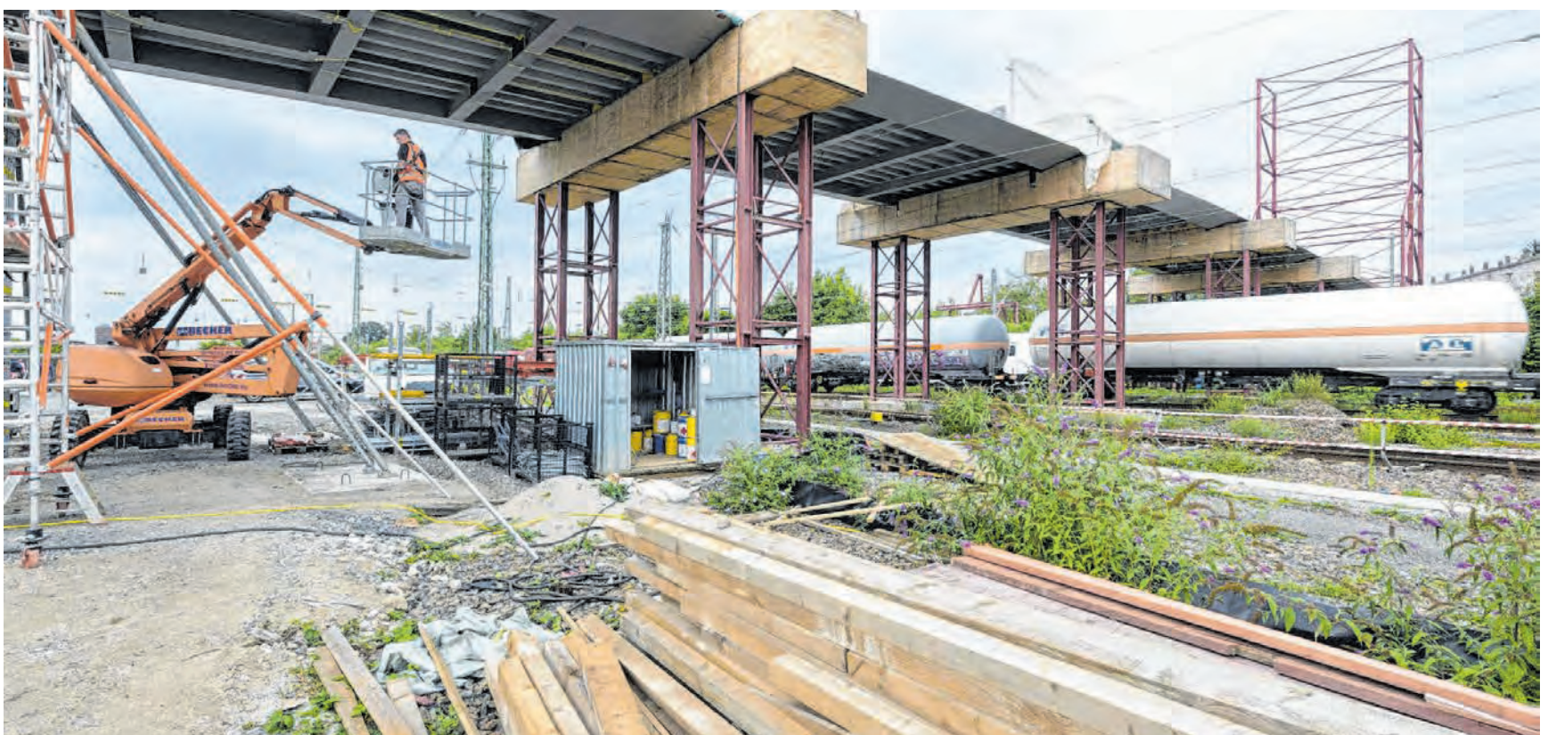
Die Gneisenaubücke wächst: Sieben Elemente sind bereits zusammengefügt und liegen auf provisorischen Trägern. Später wird die Rad- und Fußgängerbrücke an Seilen in der Luft hängen.
