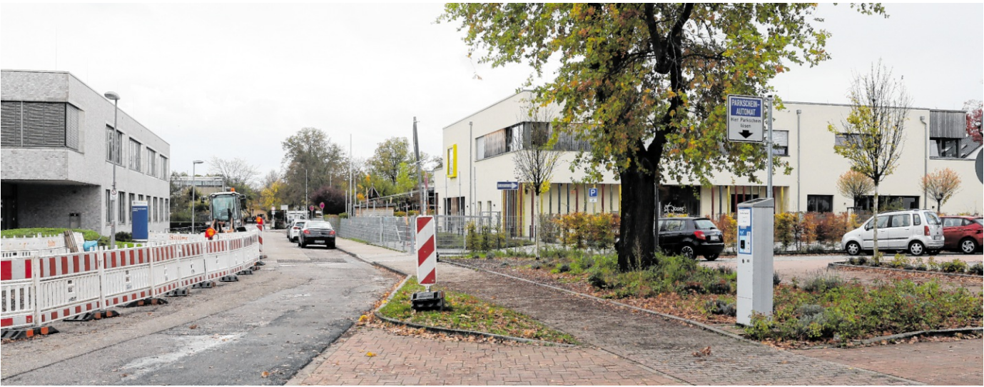
In der Schubertstraße sollen zwei Berliner Kissen in Höhe der Einfahrt zum Parkplatz Schülermensa sowie zwischen dem Kindergarten St. Josef und Louise-Otto-Peters-Schule installiert werden.
