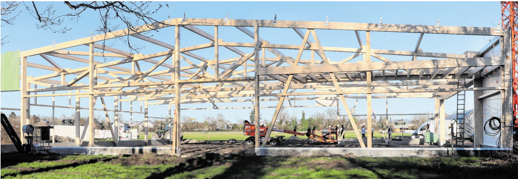
Richtfest beim Sportflieger-Club Hockenheim: Das Gerüst der neuen Flugzeughalle steht, die Verkleidung folgt in den kommenden Wochen.
