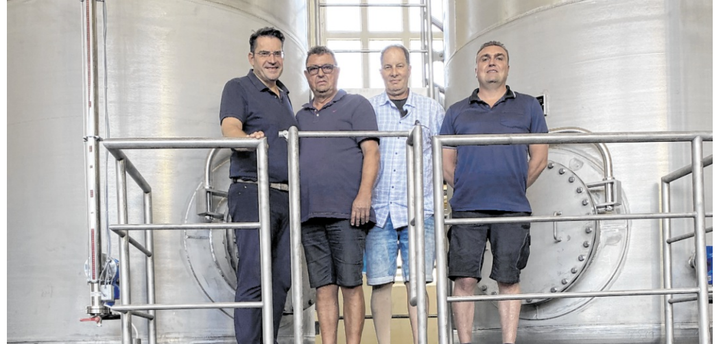
Bürgermeister Stefan Weisbrod (v.l.) die Wassermeister Thomas Wünsche, Marcus Kube und Patrick Wünsche vor den Windkesseln, die dem Druckausgleich in den Wasserleitungen dienen.
