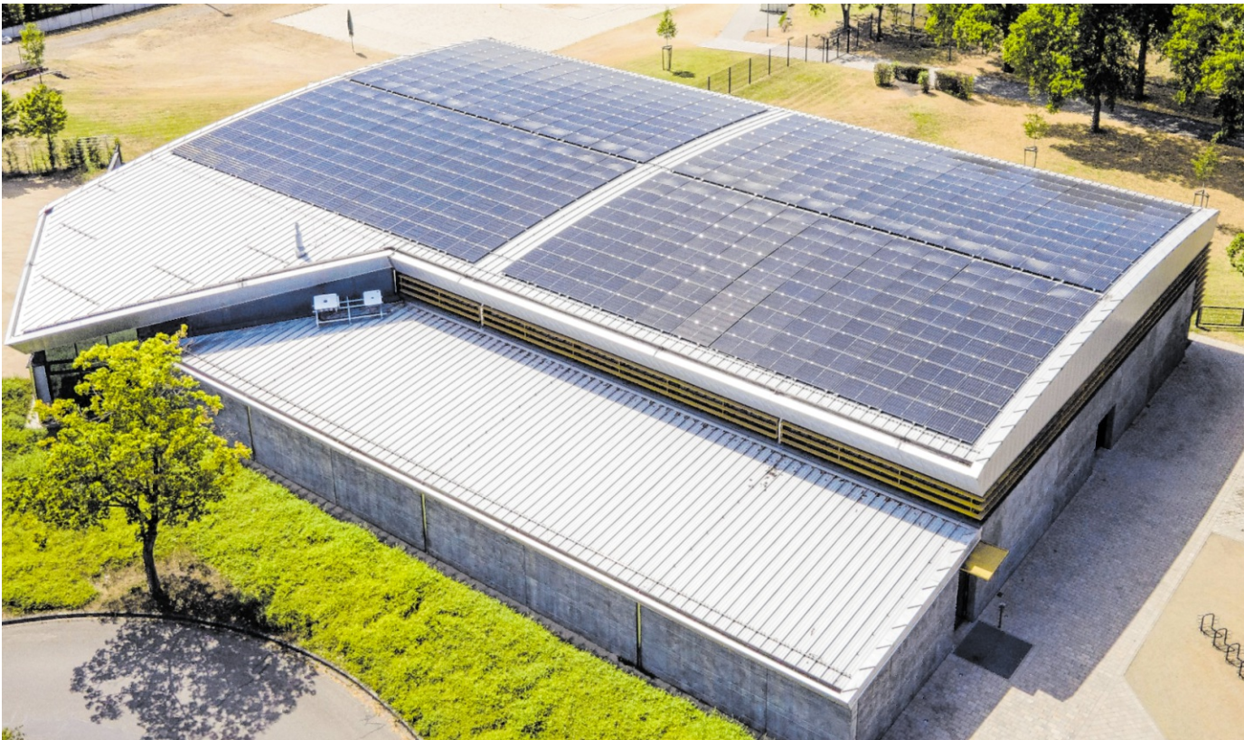
Ein Blick aus der Luft macht die Dimension des Projekts besonders deutlich: Die Dachfläche der Sporthalle-Süd ist auf 1.000 Quadratmetern mit Photovoltaikmodulen belegt.
