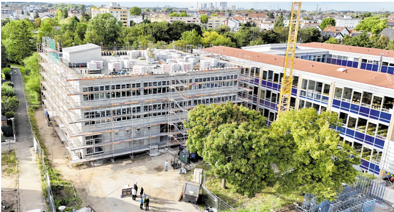
Blick auf den Rohbau: Ende 2026 soll der Sonnenschein-Hort einziehen.
