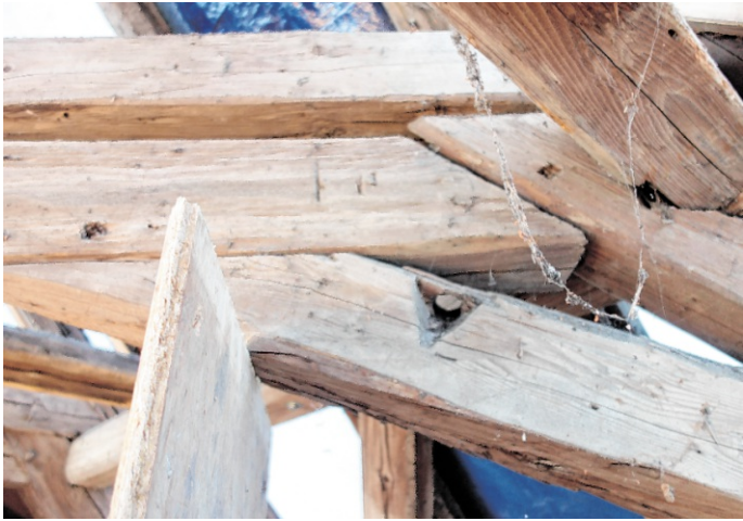
An dem 300 Jahre alten Dachstuhl des Bürgerhauses Schlierbach hat der Zahn der Zeit sichtbar genagt. Gut zu sehen sind die sogenannten Floßaugen in den Dachbalken – sie zeigen, dass die Baumstämme einst per Floß nach Heidelberg transportiert wurden.
