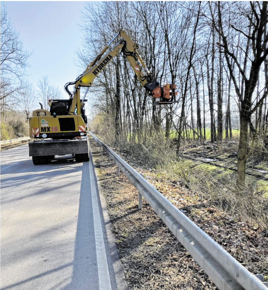
Mit Gehölzbagger und Motorsäge werden Hecken und Bäume entlang von Bundes-, Landes- und Kreisstraßen fachgerecht zurückgeschnitten.
