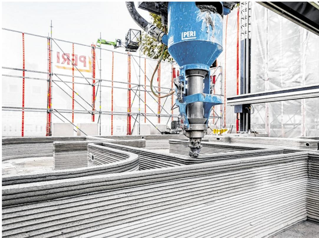
Beim 3-D-Betondruck kommt ein spezieller Druckkopf zum Einsatz. ©
