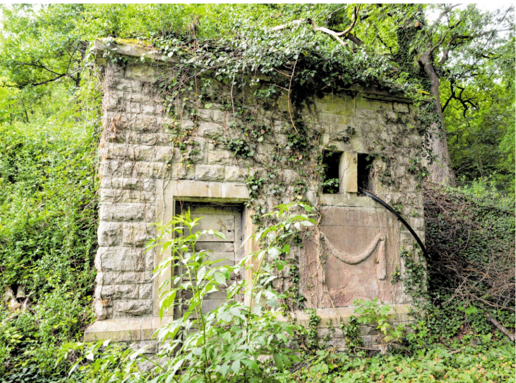
Als Zuzenhausen eine zentrale Wasserversorgung erhielt, wurden 1907-1909 zwei Quellen gefasst und in diesen Wasserhochbehälter geleitet. Zuvor hatte sich hier eine von Bürgermeister Christoph Keidel 1807 gestiftete Brunnenstube befunden, deren verzierte Abdeckplatte in dem Neubau wiederverwendet wurde.
