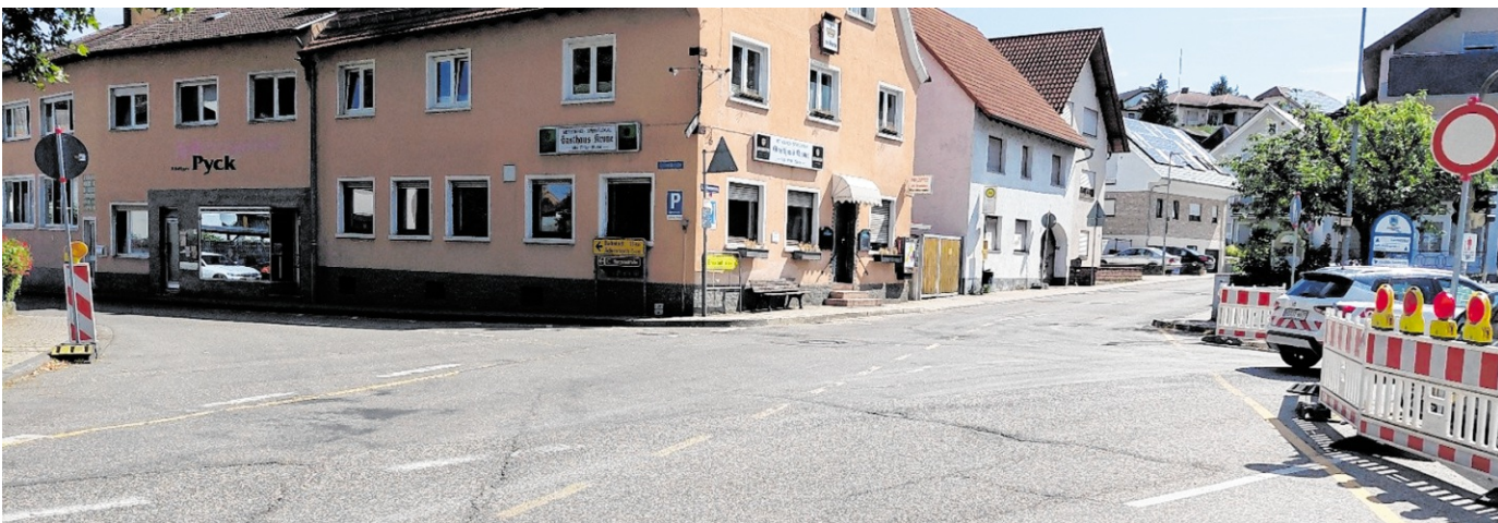
Die Sommerferien bringen eine Baustelle im Kreuzungsbereich Steinsfurter Straße / Dickwaldstraße / Lerchenneststraße.
