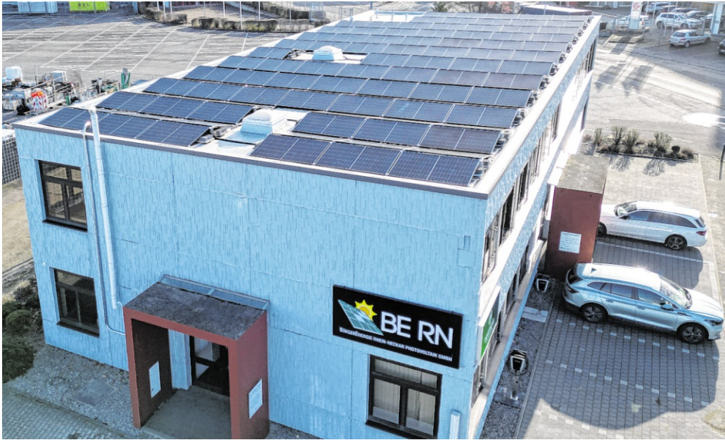
Die BürgerEnergie Rhein-Neckar Photovoltaik GmbH im EnergieCampus Sinsheim, Neulandstraße 25 macht sich stark für die gemeinsame Energiewende.
