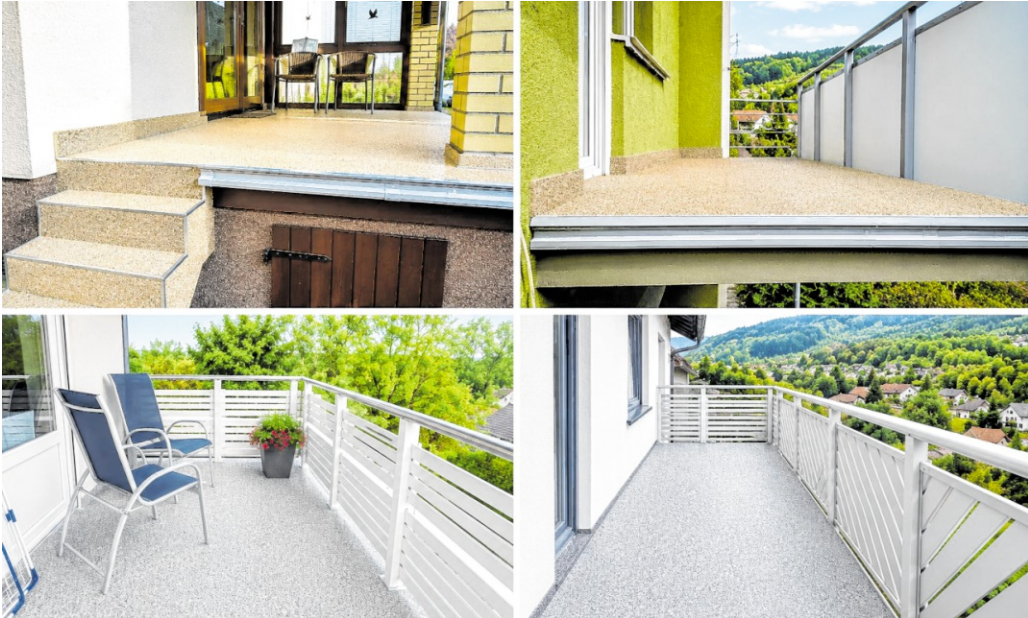
Das Sanierungssystem verbindet moderne Gestaltung mit kontrollierter Entwässerung und geringer Aufbauhöhe. BILD: C. SCHMITT
