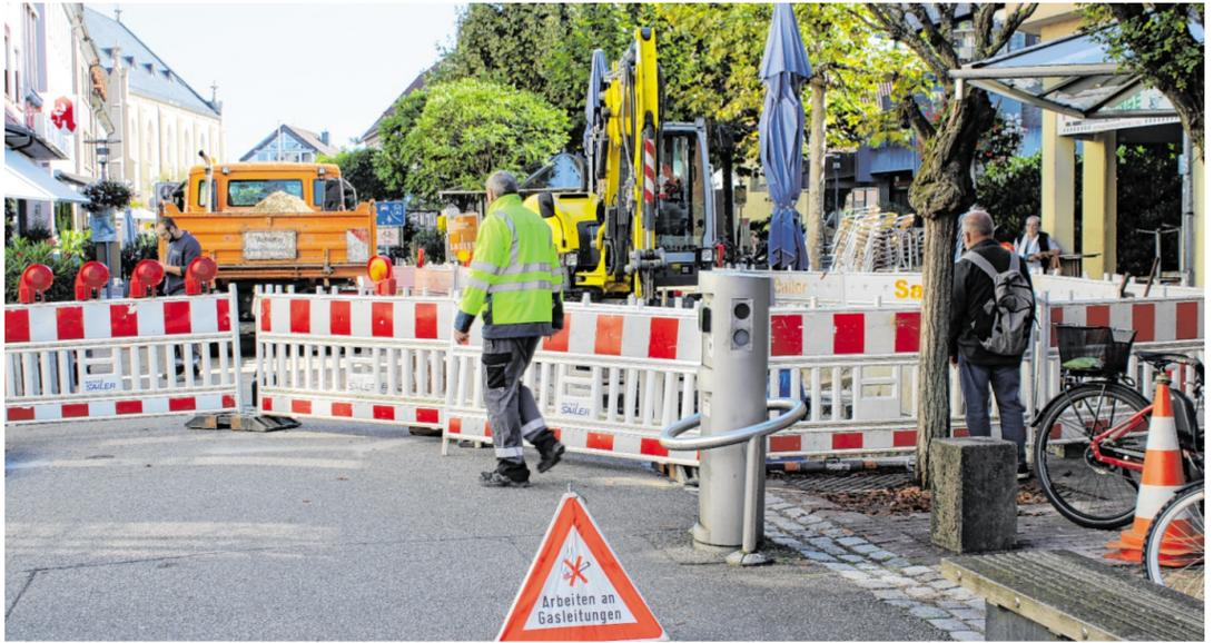
Das Gasleck in der vorderen Hauptstraße wurde zunächst provisorisch abgedichtet. In den kommenden Tagen wird der betroffene Teil der Leitung ausgetauscht. Eine Gefahr für die Bevölkerung bestand nicht.
