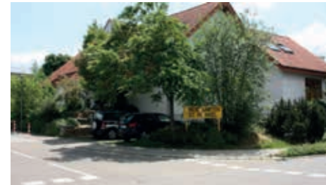
Kindergarten St. Michael, Nußloch. Bild: Gemeinde Nußloch
