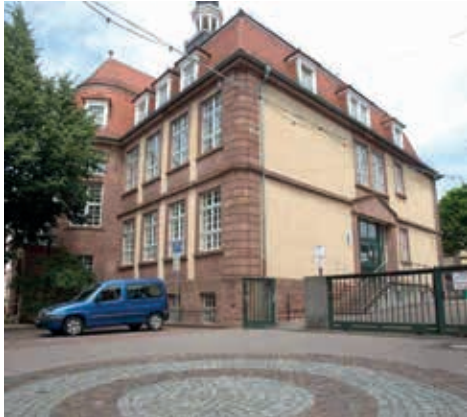
Turmschule in Leimen.
