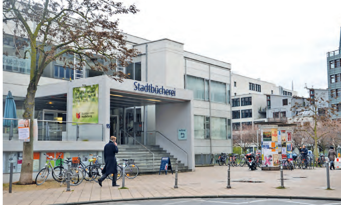
Blick auf die Heidelberger Stadtbücherei in Rohrback.
