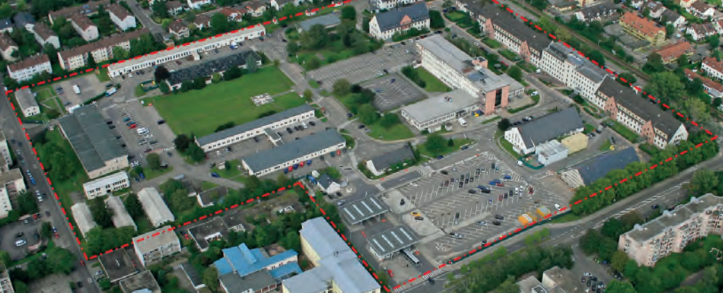
Gesamtüberblick über die Liegenschaft US-Hospital.
