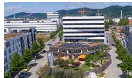
Kurze Wege: Kita umgeben von Büros.
