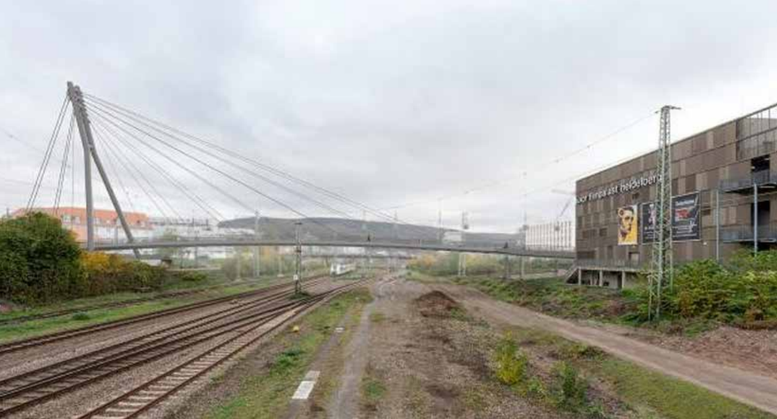
Die neue Gneisenaubrücke überspannt künftig vier Bahn- und zwei Straßenbahngleise nahe der Czernybrücke. Bild: Stadt Heidelberg
